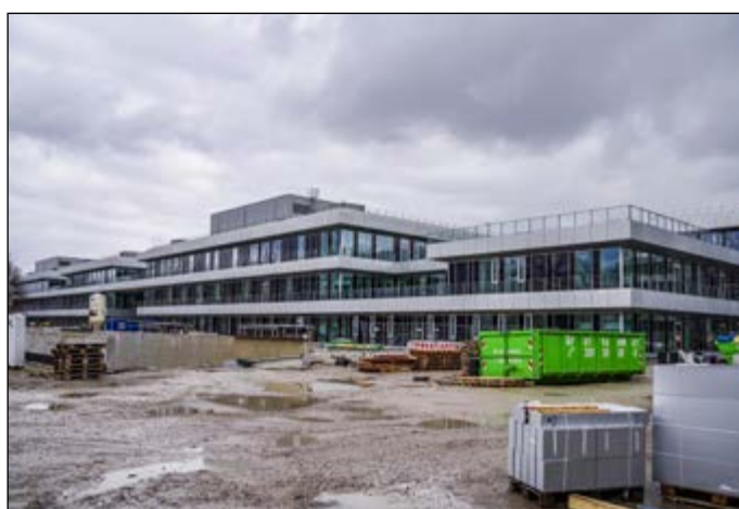
Noch ist es eine Baustelle. In drei Jahren sollen im neuen Fernsehzentrum des BR rund 1000 Mitarbeitende crossmediale Inhalte produzieren.
